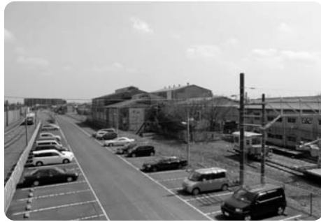
東武動物駅西口杉戸工場跡地 (年末頃から建屋の解体撤去作業予定)
