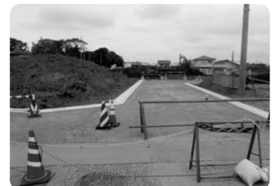
道々々と工事が進む道仏地区土地区画整理地内
